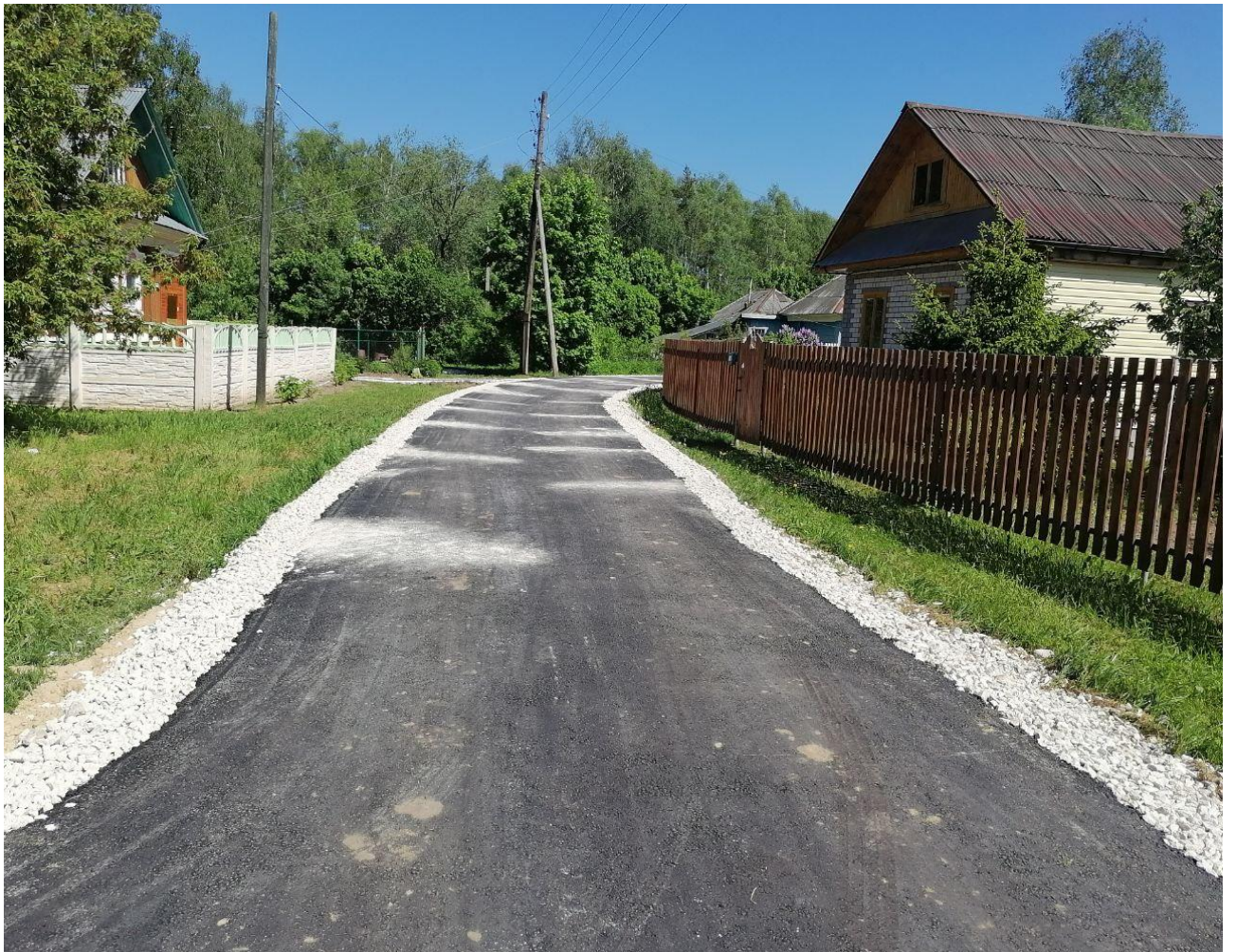
д. Жуково (участок асфальтированной дороги)
